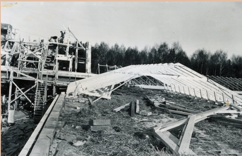
Takkonstruktionen bygges
