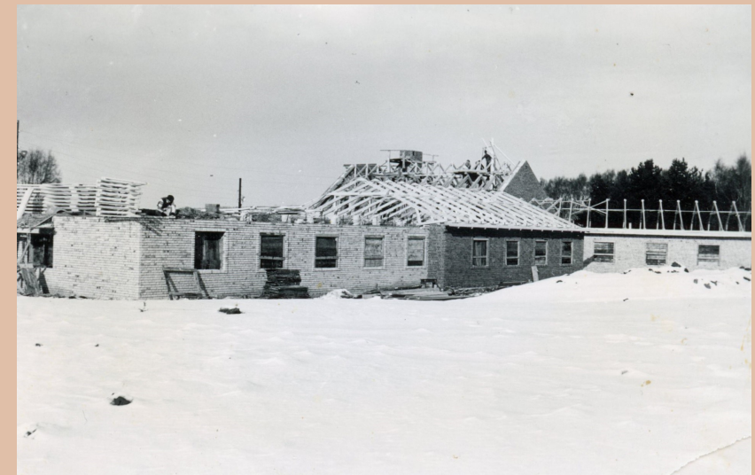
Takkonstruktionen bygges
